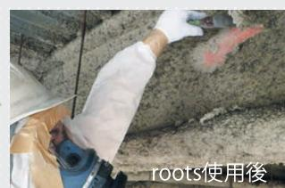
吹付け石綿の除去作業前に噴霧することで、作業中のアスベスト飛散を抑制し、より安全な作業空間を作ることができます。
