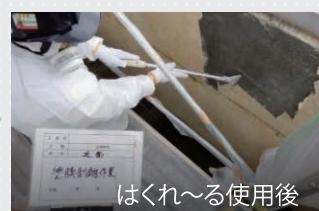
外壁仕上げ途材の融解と、途材に含まれるアスベストの固着により粉塵の飛散リスクを最小限に安全かつスムーズに除去することができます。
