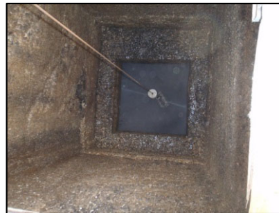
①ウォータージェット除去 高圧水洗機器を用いて高水圧で石綿を除去を実施する。
