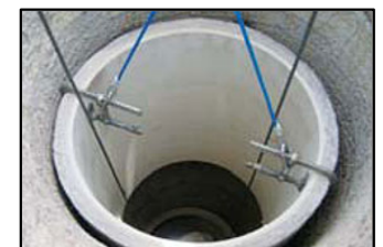
④ライニング材取り付け 細かく分けて煙突に入れ込みモルタル等で固定する。
