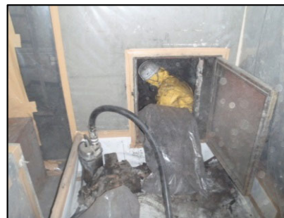
②廃石棉回収 高水圧で落下した廃石棉を回収する。
