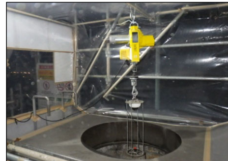
①煙突内部専用噴霧器 360° 噴霧可能な専用機器を用いて 封じ込めを実施する。
